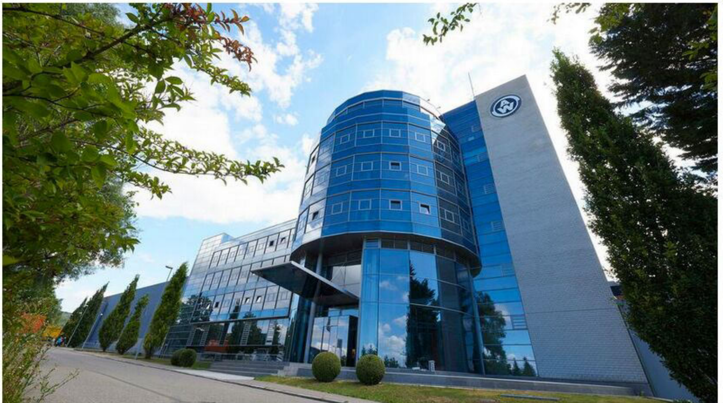
Zentrale von Weber in Markdorf
